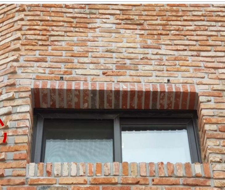
평택 비전동 984-*번지 일반 주택 외벽보수공사 (후)
