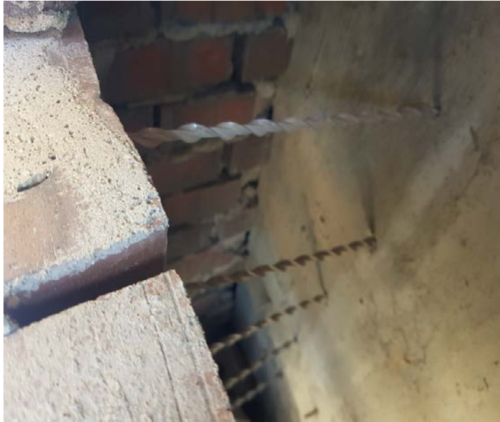
전북대학교 평화관 하이픽스 보강공사 (하이픽스 압입 후)
