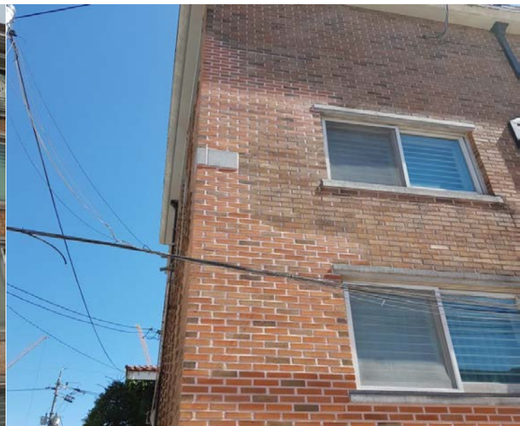
과천 향교말길 15-*번지 일반주택 외벽보수공사(후)
