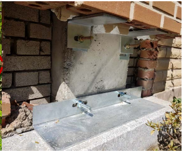
용인 현암고등학교 외벽보수공사 (후)
