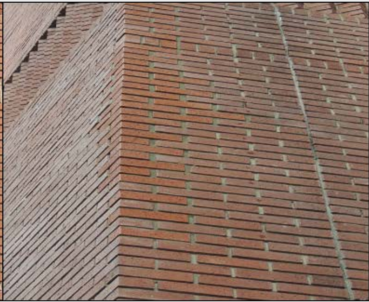
중앙대학교 중앙문화예술관 공사(후)
