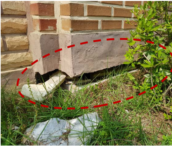
용인 현암고등학교 외벽보수공사 (전)
