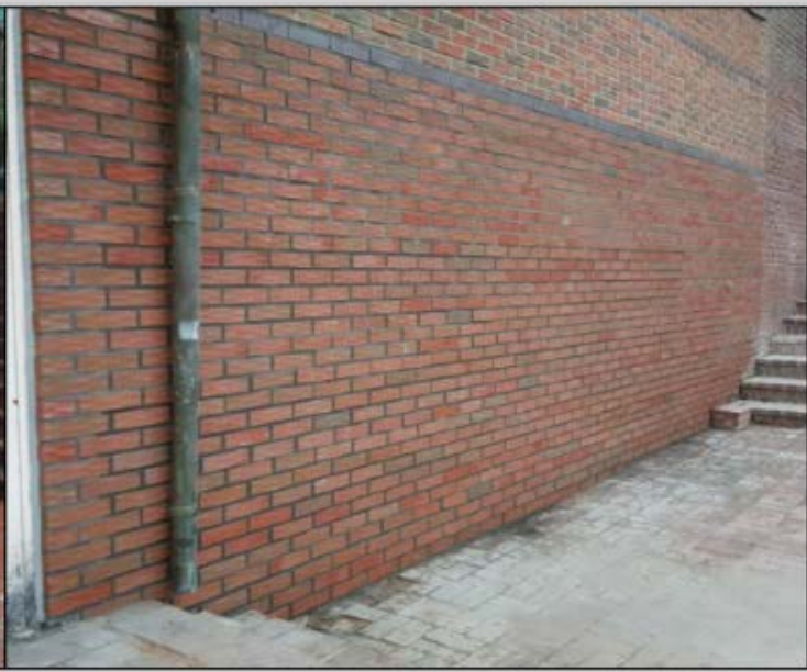
가톨릭관동대학교 제3생활관 기계실 공사(후)
