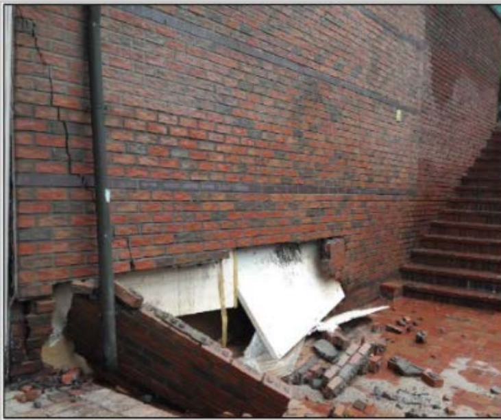
가톨릭관동대학교 제3생활관 기계실 공사(전)
