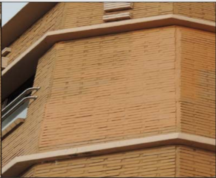
장성중학교 외벽보수 공사(후)
