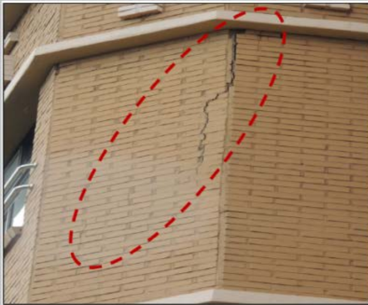
장성중학교 외벽보수 공사(전)
