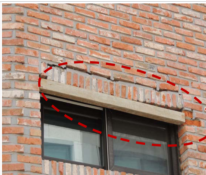
평택 비전동 984-*번지 일반 주택 외벽보수공사 (전)
