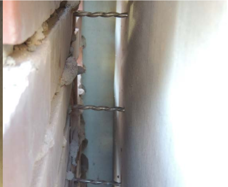
전북대학교 평화관 하이픽스 보강공사 (하이픽스 압입 후)
