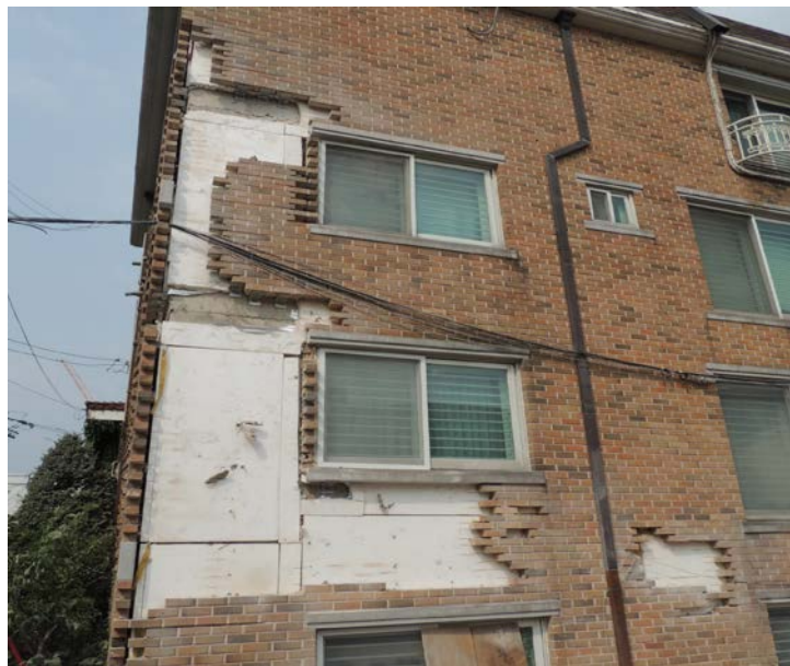
과천 향교말길 15-*번지 일반주택 외벽보수공사 (전)
