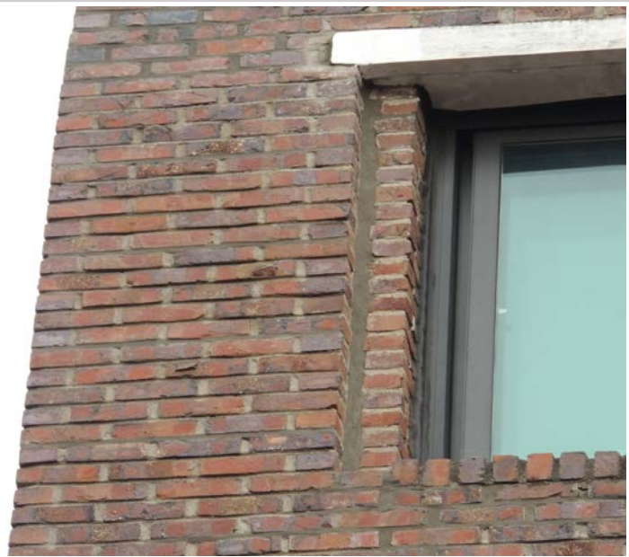
충북대학교 법학관 균열보수 (후)
