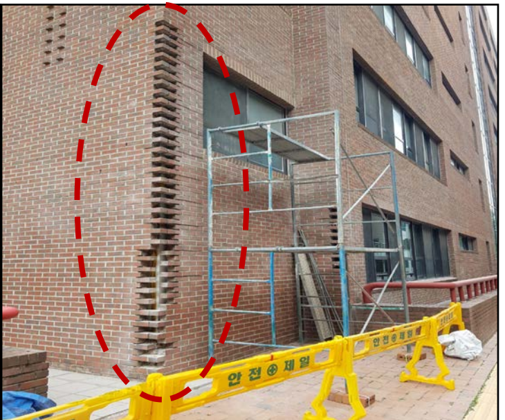
우송대학교 국제경영센터 외벽보수공사(후)
